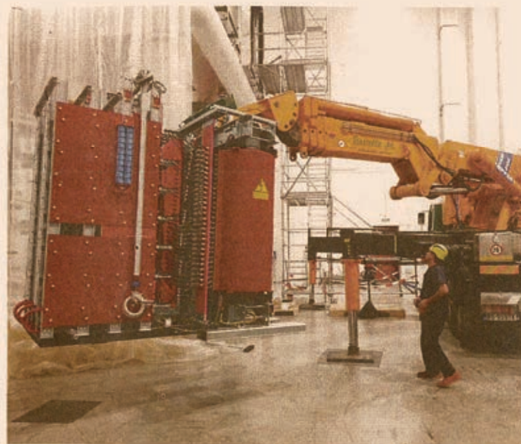
Sistemi avanzati. L'installazione di linee Iseps nel Mitica high-voltage deck presso il Consorzio Rfx di Padova
